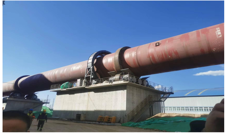
脱水车间（建设中）
