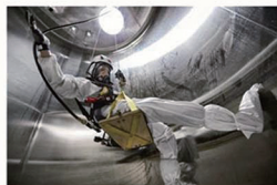
进入储罐作业
