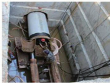
深基坑和地下管沟
